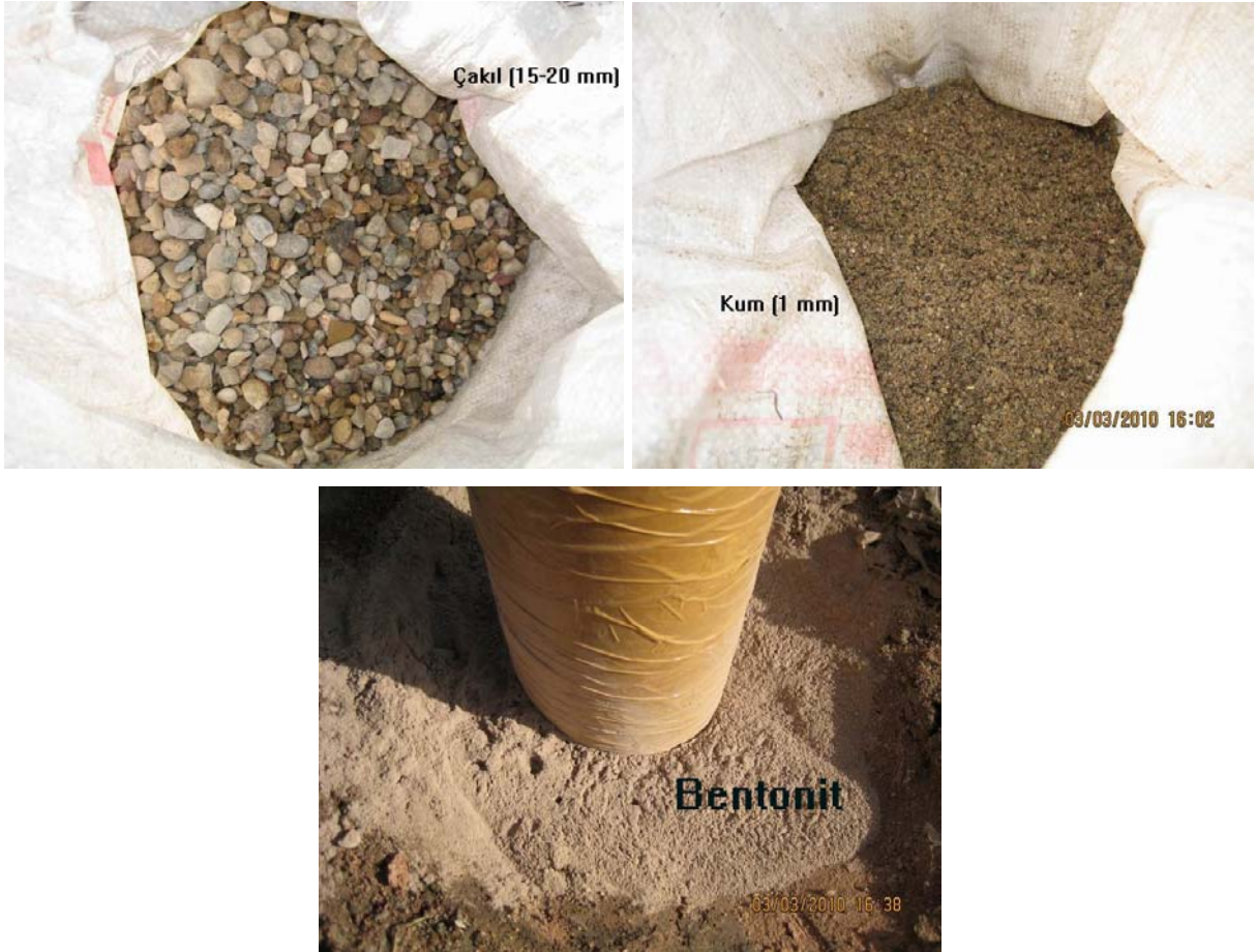
Şekil 66: Perfore boru ile gaz ölçüm kuyusu arasına yerleştirilen dolgu malzemeleri
