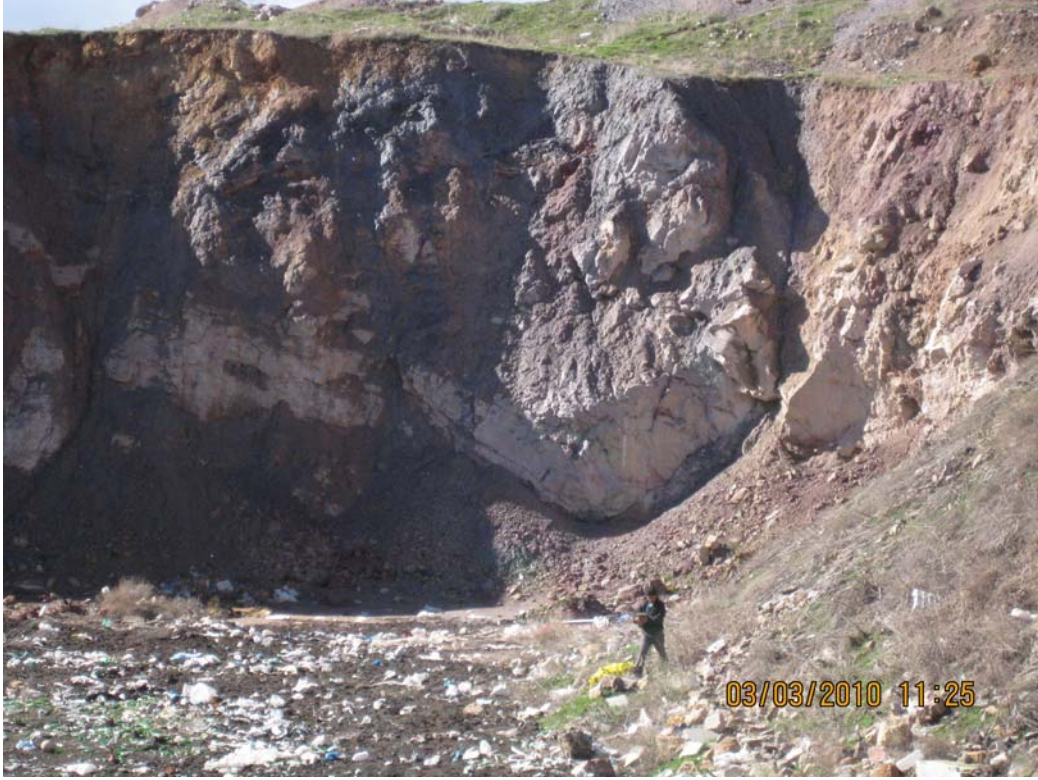
Kaya Yapısı ve Çatlaklar
