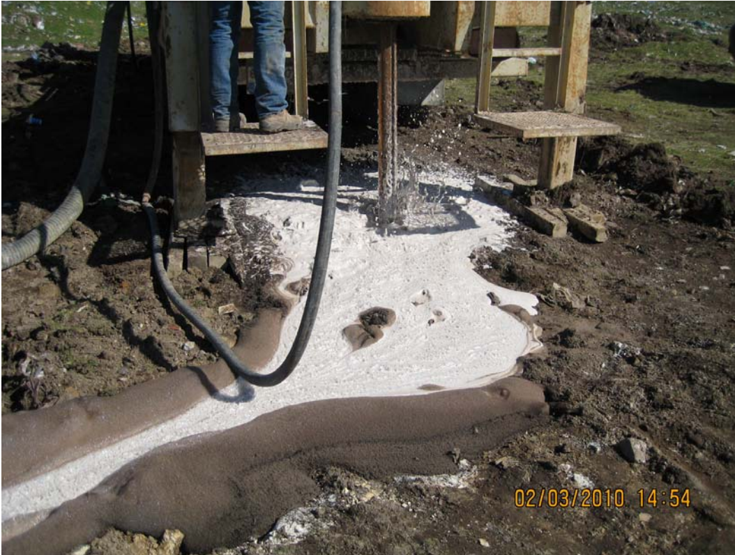
Deponi Gazı (LFL) Gözlem Bacası Sondaj Çalışmaları(Köpüklü Sondaj)
