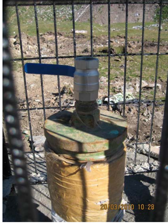
Şekil 65: Küresel vana monteli gaz ölçüm borusu
