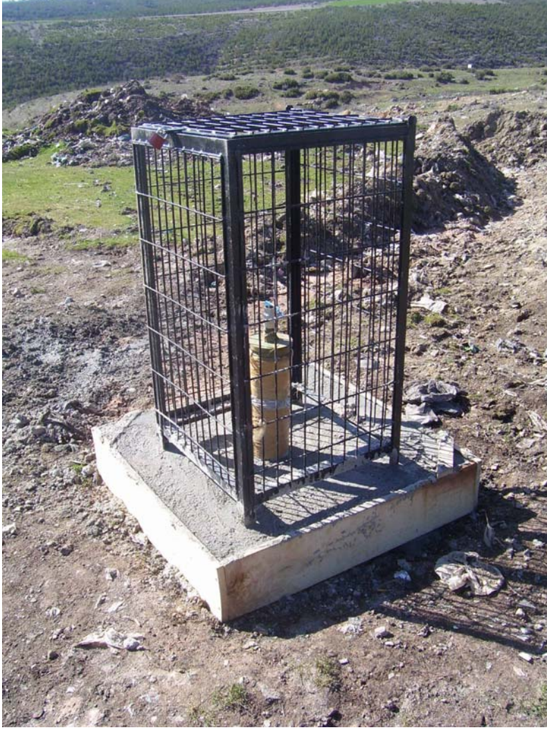
Sondajla Açılan ve Kontrol Altına Alınan Gaz Bacasının Nihai Hali
