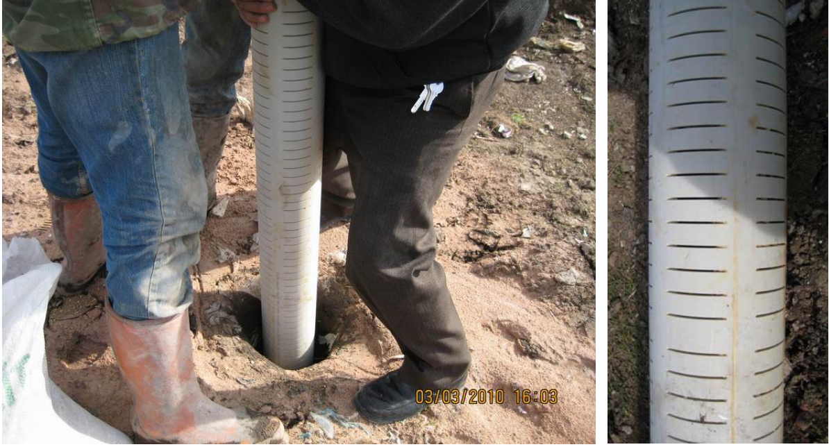
Şekil 62: Sondaj deliklerine yerleştirilen perfore PVC boru
