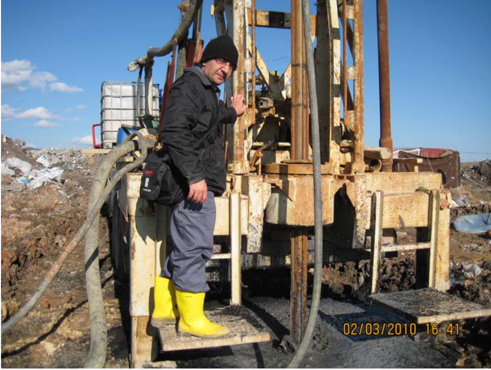
Gözlem Bacası Sondaj Çalışmaları
