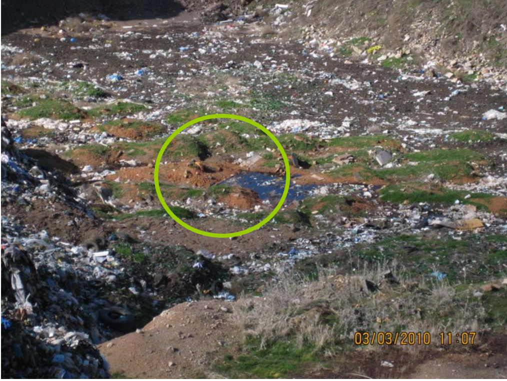
Depolama Alanında Tespit Edilebilen Tek Sızıntı Suyu Birikintisi
