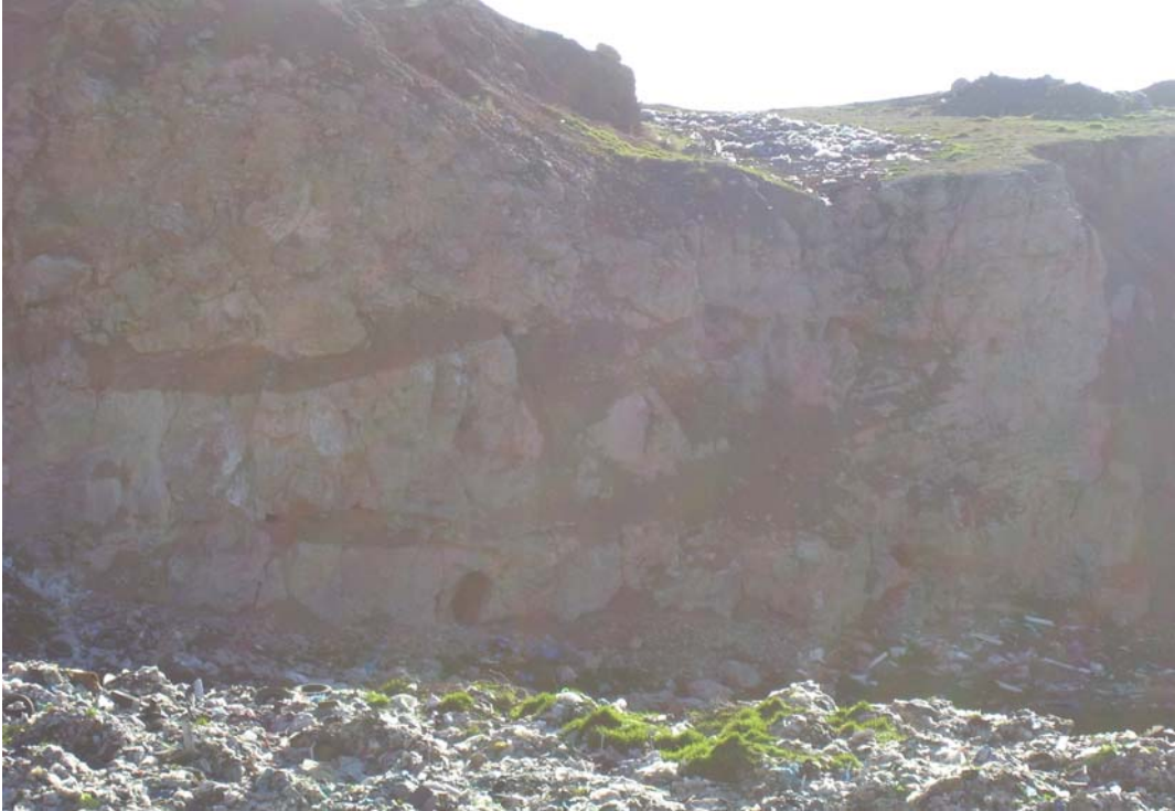
Çatlaklı ve Geçirimli Kayaların Yakın Görüntüsü
