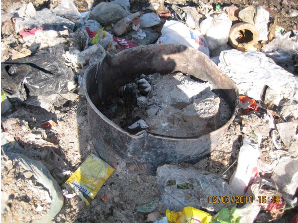
Önceden Yerleştirilen ve Atıl Hale Gelen Bir Gaz Bacası (Derinlik 6 m)
