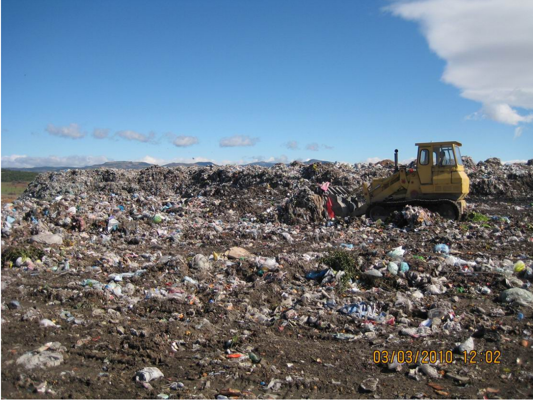
Şekil 4. Katı Atık Depolama Sahasında Çalışan Kompaktör
