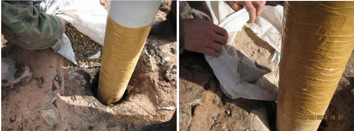
Şekil 63: Perfore boru kenarına doldurulan çakıl ve kum
