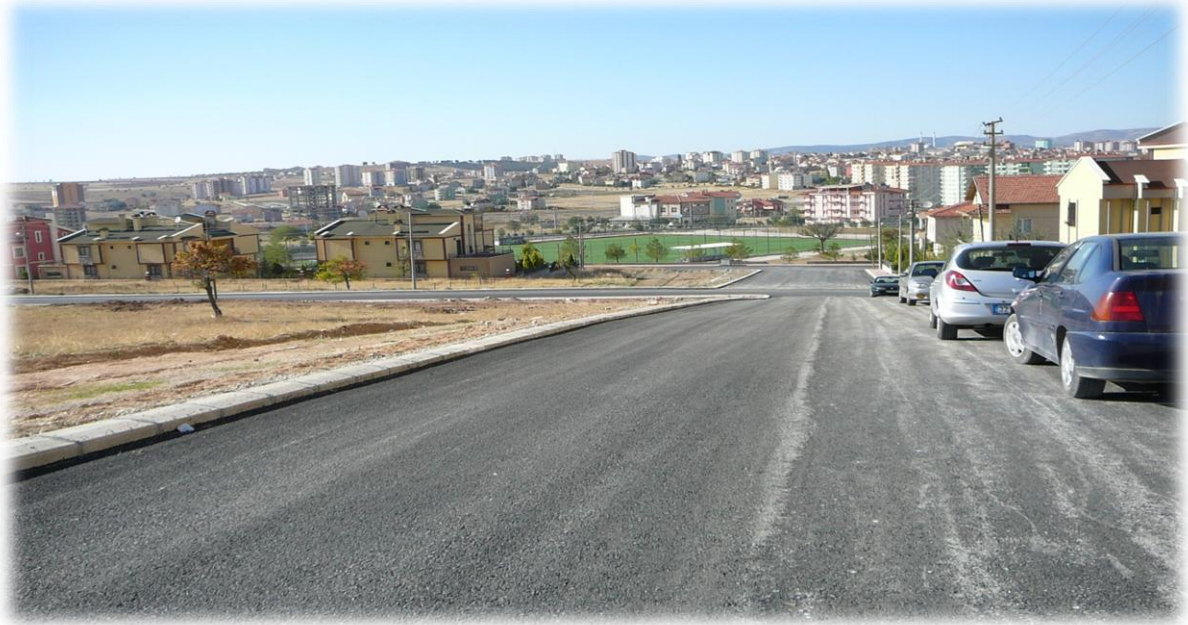
Huzurkent asfalt yol yapım çalışması
