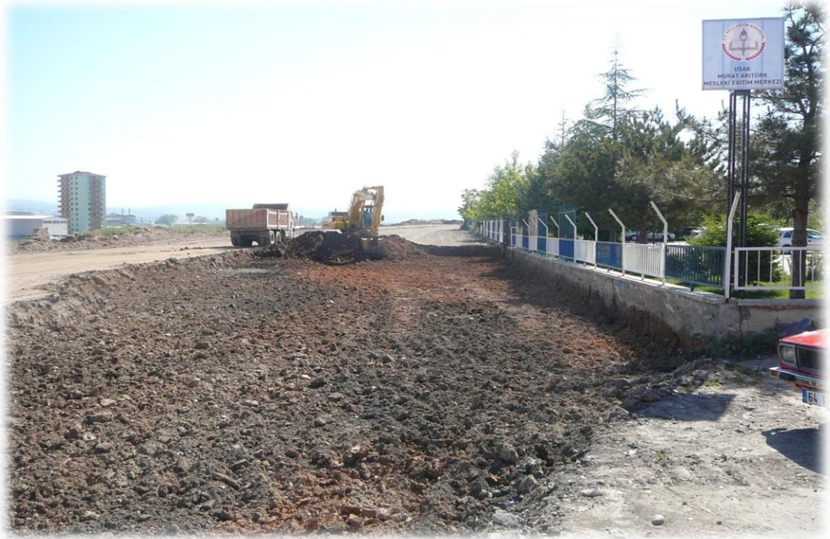
İMAR YOLU - HAM YOL AÇMA ÇALIŞMALARI Fevzi Çakmak Mahallesi Sanayi cd.
