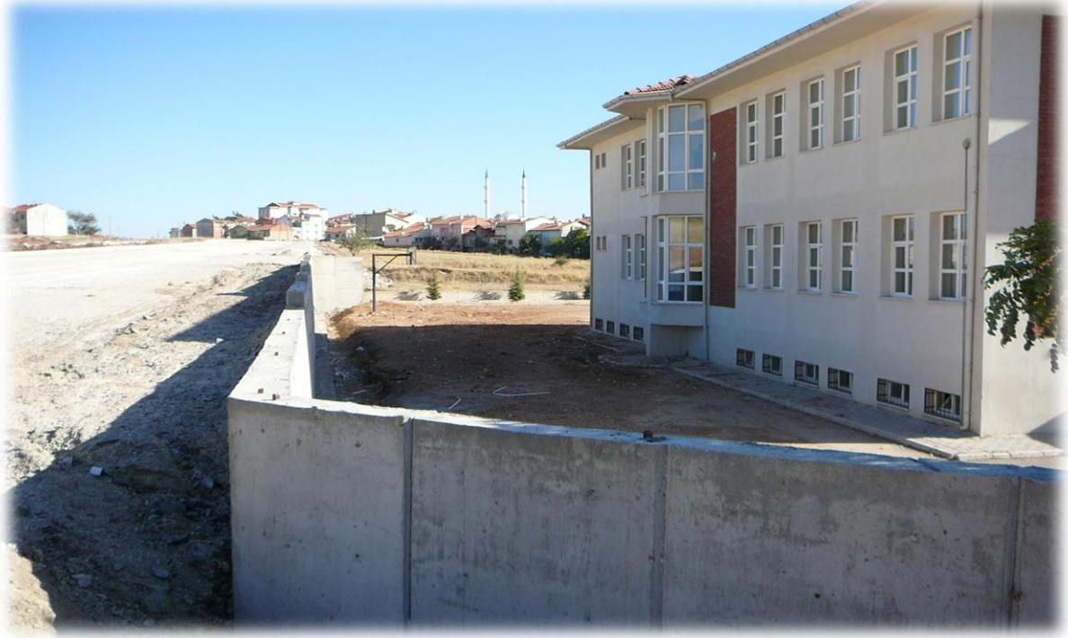
İstinat duvarı yapımı: Yaşar Akar İlköğretim Okulu
