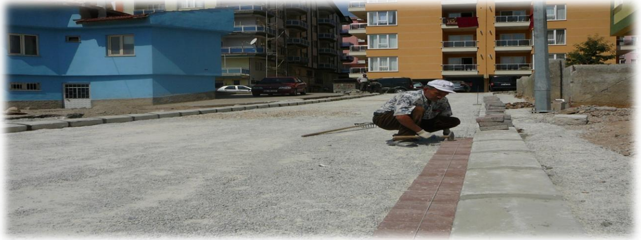
Cumhuriyet mahallesi 2. mersin sokak beton parke yol yapım çalışması
