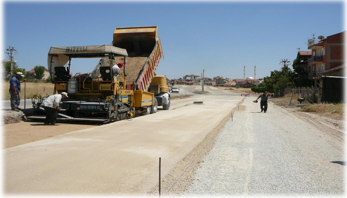
İbrahim Tahtakılıç caddesi Asfalt ön hazırlık, finişerle bitümlü sıcak karışım serme çalışması
