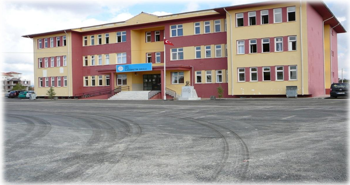
Okul Bahçesi asfaltlama: Gül İlköğretim Okulu
