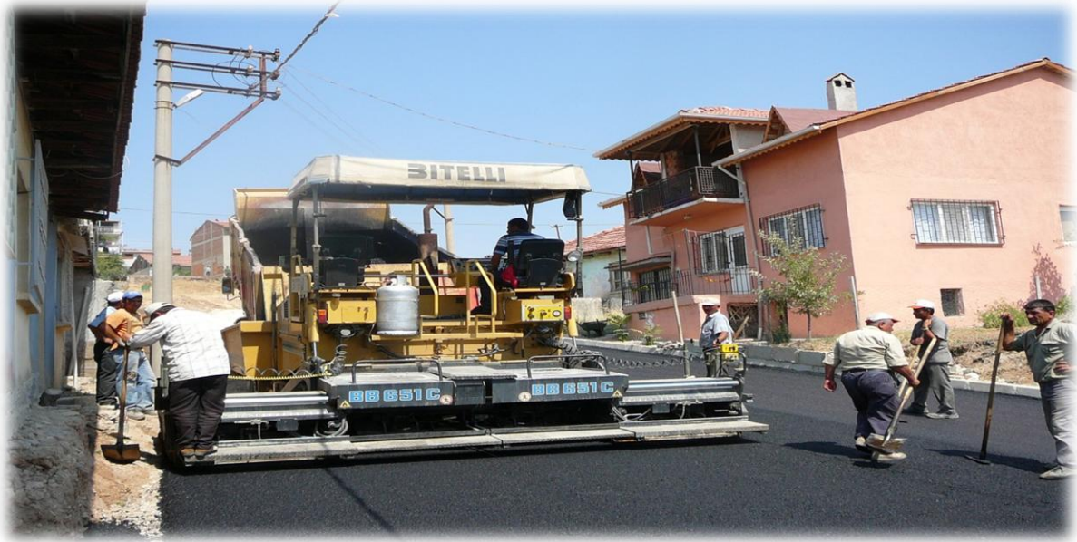
Işık Mahallesi çeşitli sokaklarda asfalt yol yapım çalışması
