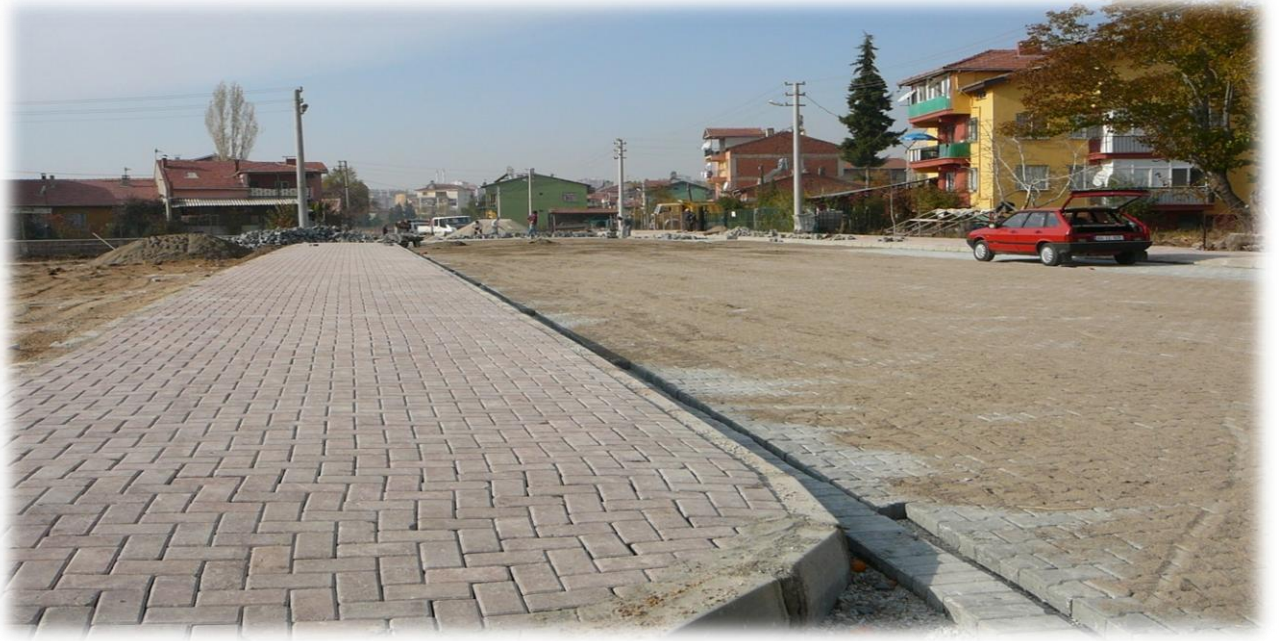
Muhtelif cadde ve sokaklar beton parke yol tamir çalışması
