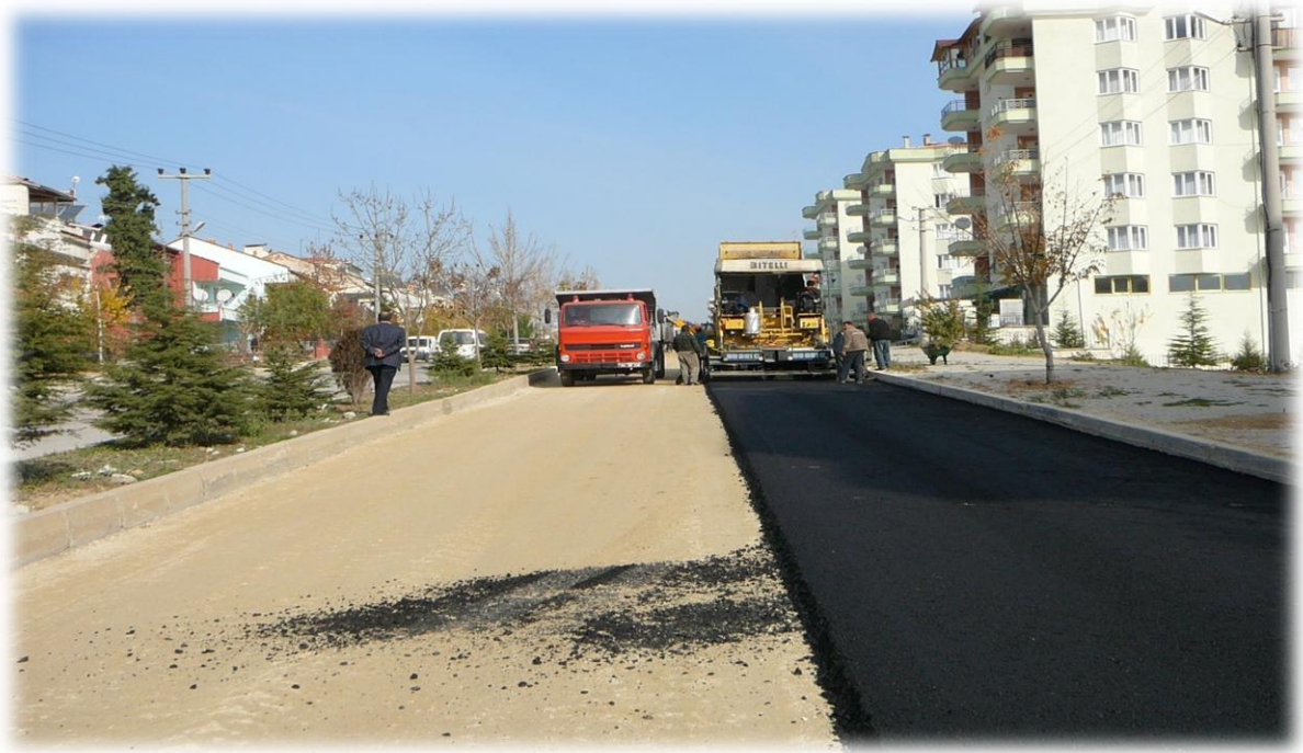
Asfalt yol yapım çalışması Uğur MUMCU caddesi
