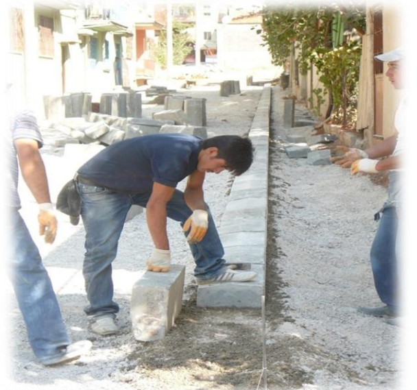
İbrahim Tahtakılıç caddesi beton parke kaldırım çalışması
