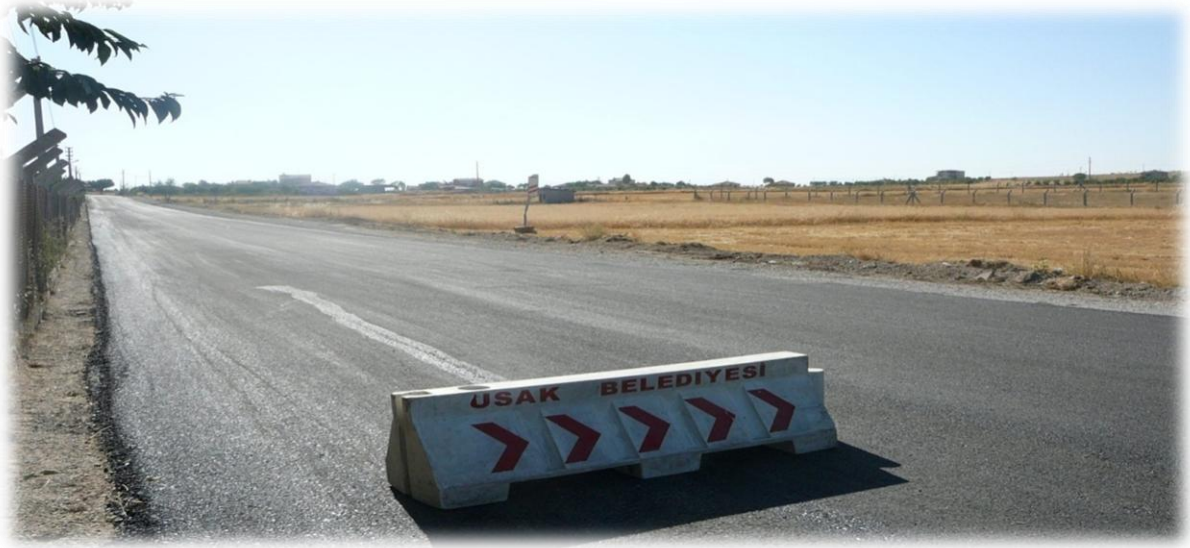
Fatih Mahallesi Seramikçiler Sitesi civarı asfalt yol yapımı
