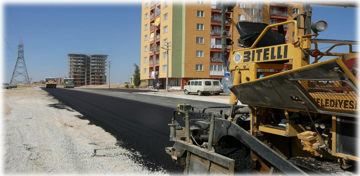
Fatih mahallesi yavuz sultan selim cad. asfalt yol yapım çalışması
