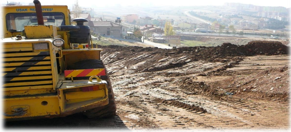
Karaağaç mahallesi muz sokaklar yol açma çalışması
