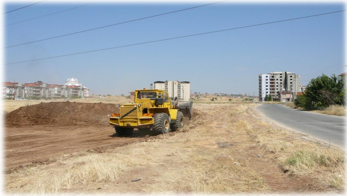
Şehit Basri Bey Caddesi yol açma çalışmaları
