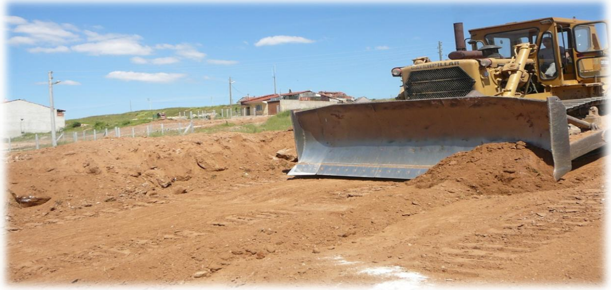
Karaağaç mahallesi muhtelif sokaklar yol açma çalışması
