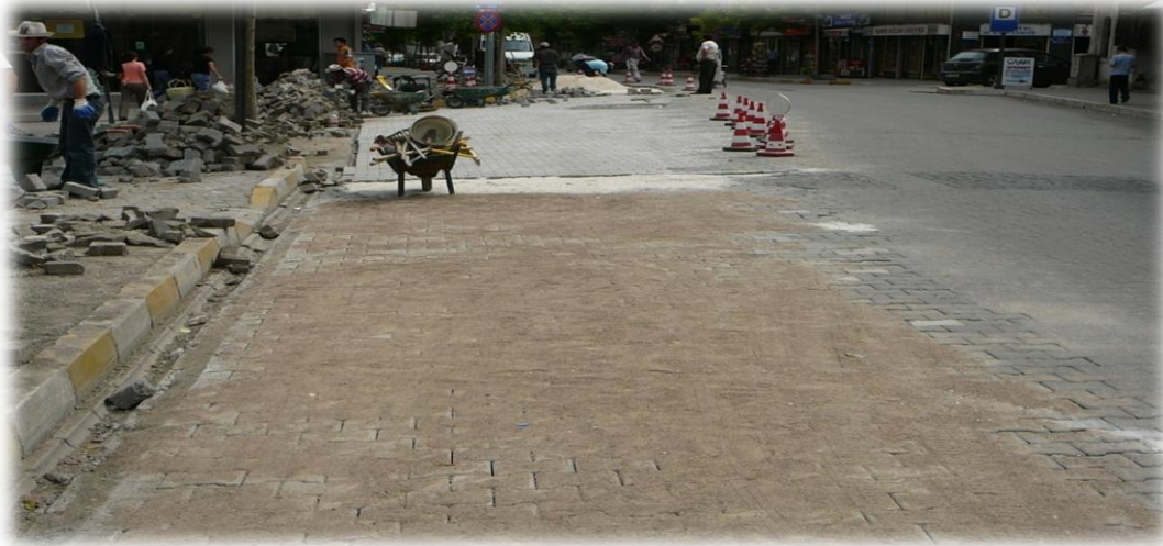
Zübeyda Hanım caddesi beton parke tamirat çalışması
