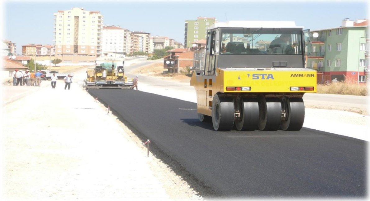
Cumhuriyet mahallesi İbrahim Tahtakılıç Caddesi asfalt yol yapım çalışması
