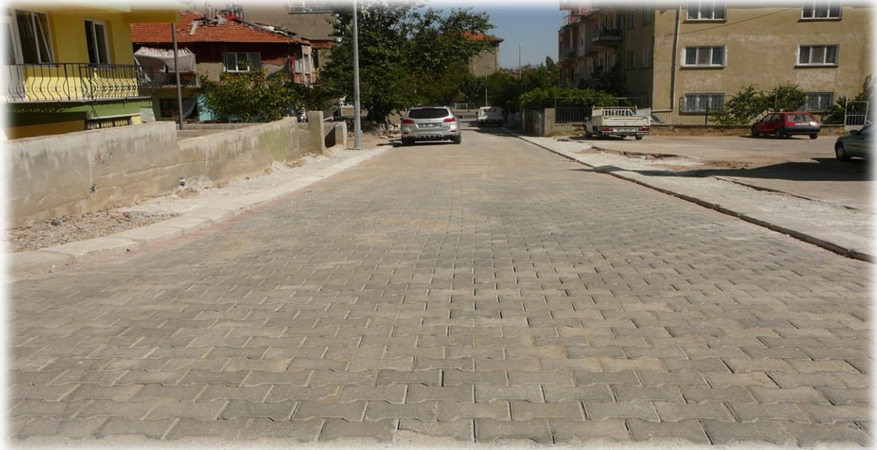
Muhtelif cadde ve sokaklar beton parke yol tamir çalışması
