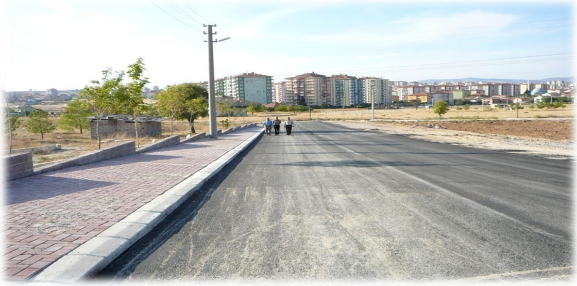
Huzurkent asfalt yol yapım çalışması
