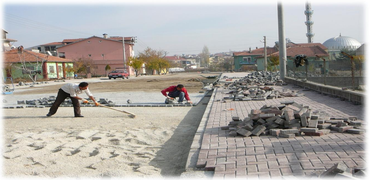
Fatih mahallesi Ezgi sokaklar beton parke yol ve kaldırım çalışması
