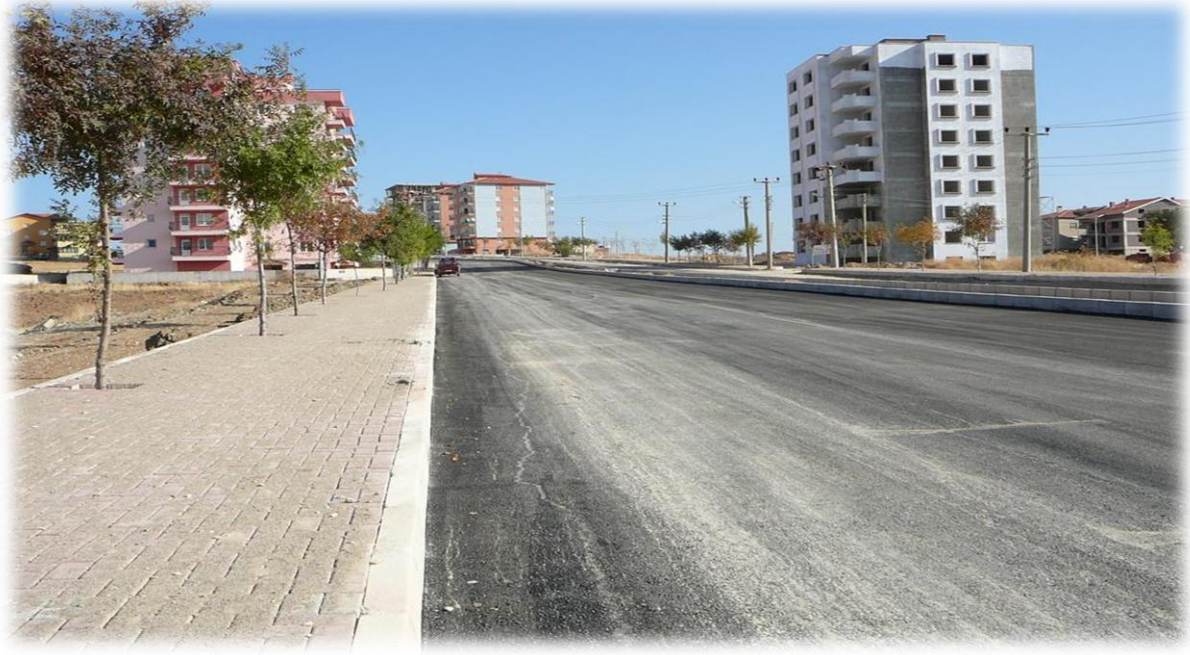
Cumhuriyet mahallesi Uğur Mumcu caddesi asfalt ve kaldırım çalışması
