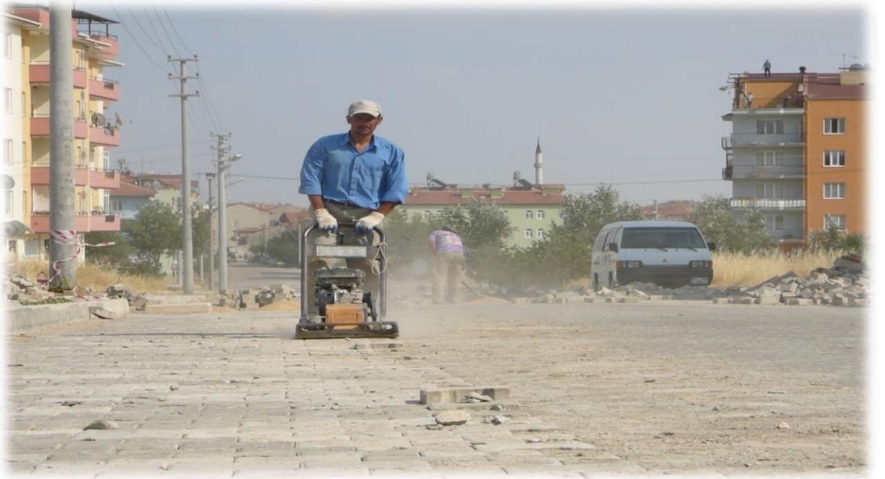
Muhtelif cadde ve sokaklar beton parke yol tamir çalışması
