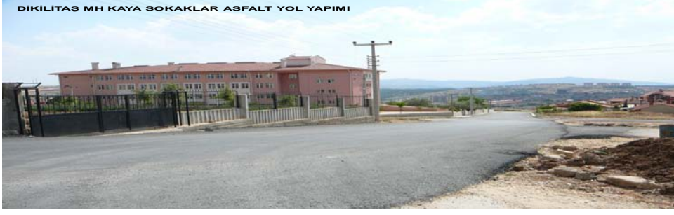
DIKİLİTAŞ MH KAYA SOKAKLAR ASFALT YOL YAPIMI
