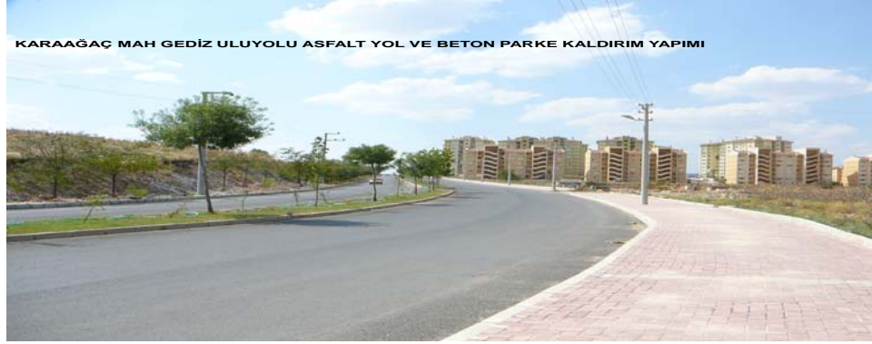
KARAĞAÇ MAH GEDİZ ULUYOLU ASFALT YOL VE BETON PARKE KALDIRIM YAPIMI
