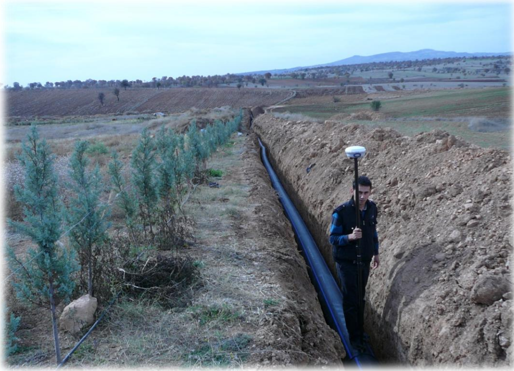
➤ ATATÜRK MAHALLESİ İNŞAATÇILAR SİTESİ İÇME SUYU HATTI
