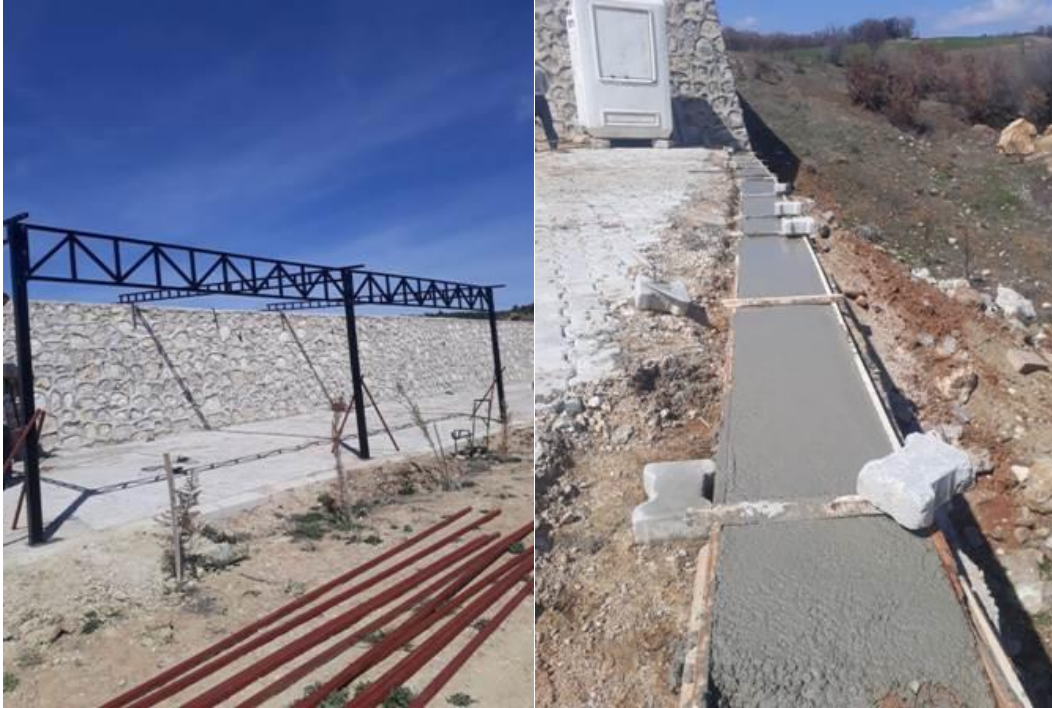
Karakaya Mezarlığı'nın giriş kapısı yapılmış, mezarlık içinde araç ve yürüyüş yolları yapılmış ve mezarlık duvarının üzerine panel tel çekilmiştir.
