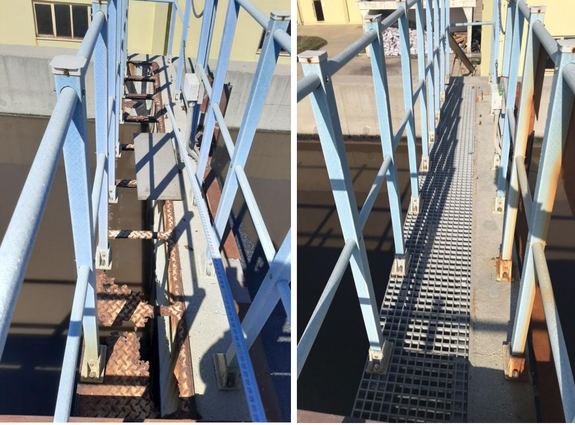
Resim 9: Çürümüş köprü yerine CTP yürüme yolları
