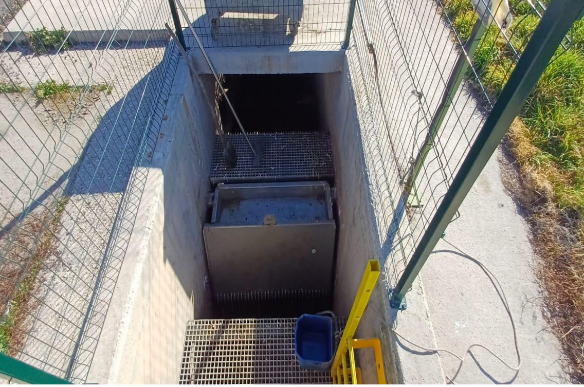
Resim 7: Manuel Kaba Izgara Revizyonu
