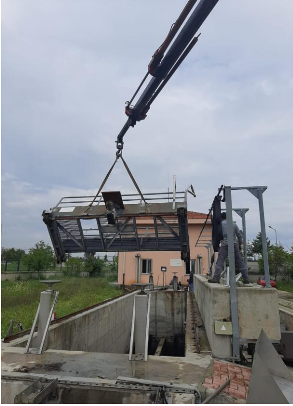
Resim 3: Revizyon Öncesi Arızalı Köprü
